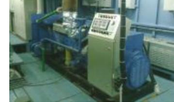
特别运用了我厂有自主知识产权的滤波绕组新型绕组和正交谐波励磁技术,阻尼绕组上采用了宽极弧、大阻尼截面、复合节距阻尼绕组等技术,全新的AVR控制技术,这些技术的综合运用,使发电机很好地满足了电力推进系统大功率非线性负载的使用要求。
